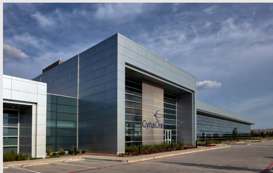
CyrusOne's Dallas-Allen Data Center in Allen, TX
